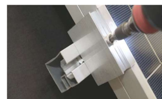
F. Skjut intill ändklämma mot solcellspanel och drag åt. Åtdragningsmoment 12 Nm
