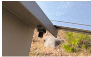
E. Fäst skena med M10 flänsnutt. Åtdragningsmoment 20–25 Nm
