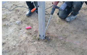
B. Förborring innan rotrör hamras ner. Kan underlätta vid steniga markförhållanden.
