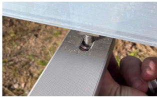
D. Vrid in T-bult i skena.
