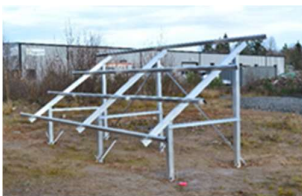
E. Montera resterande skenor.
