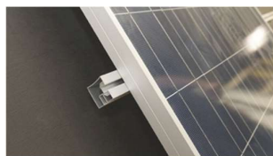
A. Placera solcellspanelen på skenor.
