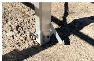
D. 4st rör per stolpe för färdigt resultat.
