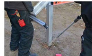
C. Hamra ner första rotröret en bit i marken. Ta fram ett nytt rotrör och hamra ner det mitt emot för att stabilisera stolpe.
