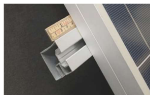
B. Skenlängd är beräknad att sticka ut 50 mm från gavel. (Max 400mm utanför gavel)
